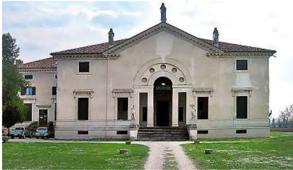
La severa, affascinante essenzialità della villa Pojana a Pojana Maggiore, opera di Andrea Palladio
